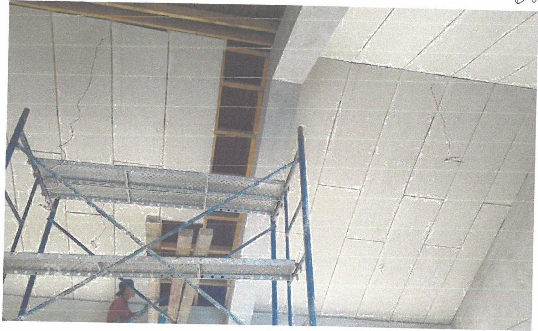
FOTO N° 05. Entramado y colocado de cielo raso en módulos de la I.E.P.B.R. Balsapuerto
