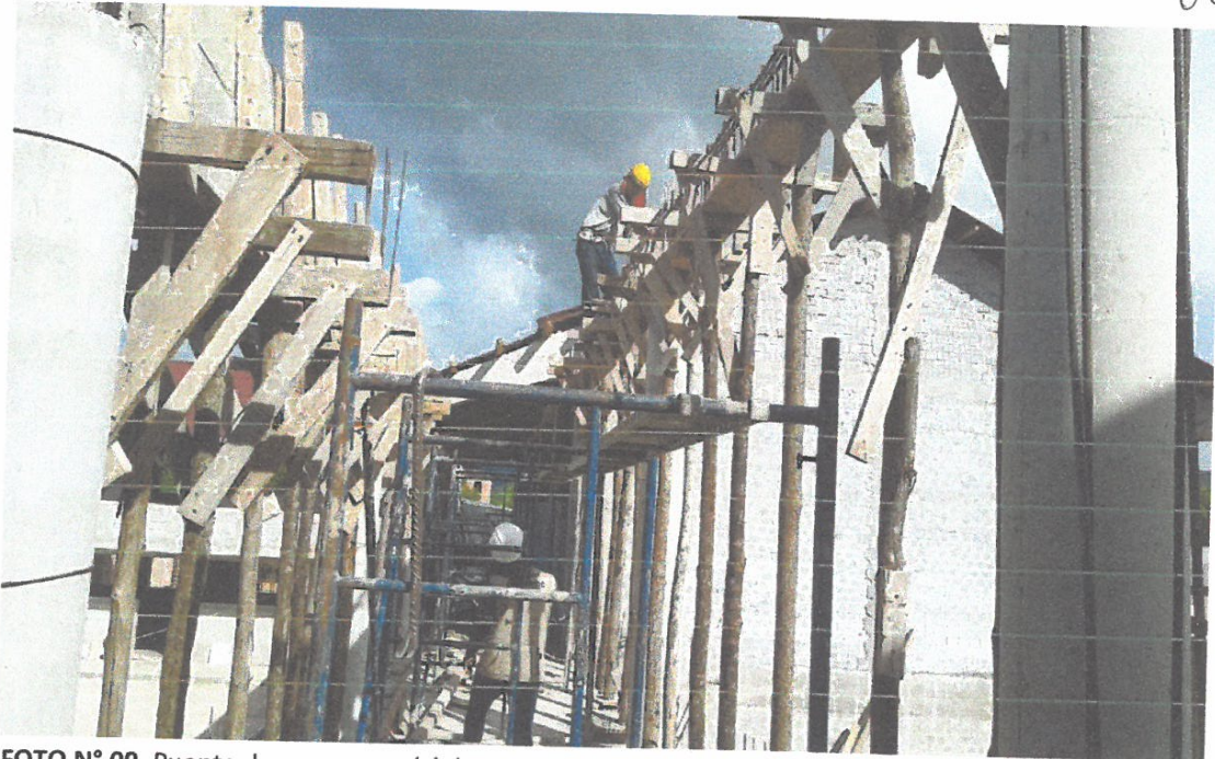
FOTO N° 09. Puente de acceso a módulos, 1, 2, 3, 4,5; la vista acusa el desarrollo de los trabajos De distribución del acero y estribado de las mismas para las vigas estructural, así como también Se evidencia los trabajos de encofrado
