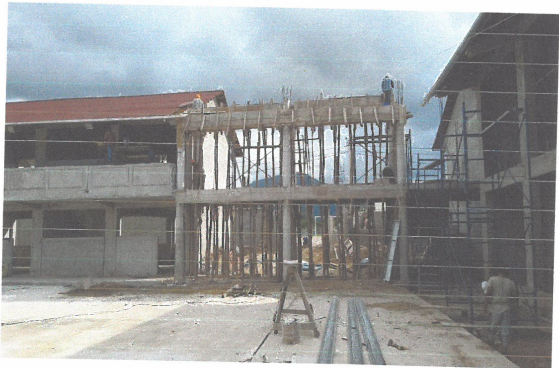
FOTO N° 10. Vista lateral del puente de acceso a módulos 1, 2, 3, 4,5; podemos observar el Desarrollo de las actividades de encofrado.
