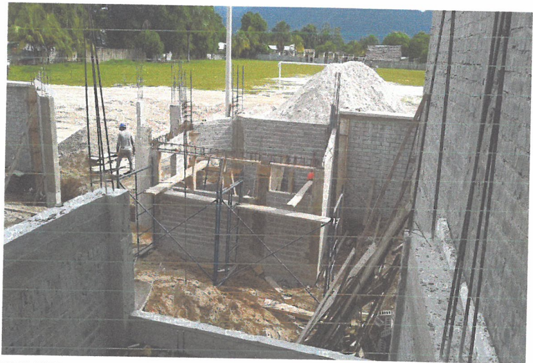
FOTO N° 06. Panorámica de los trabajos en acceso principal; la vista precisa el desarrollo de la construcción de la caseta de control de acceso a la Institución Educativa.
