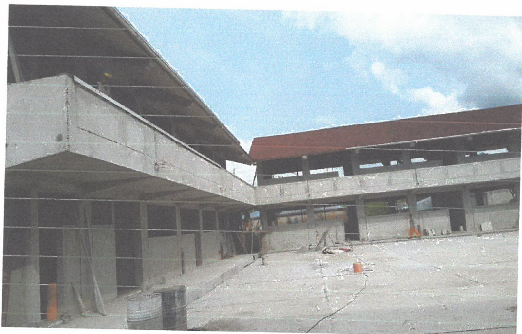
FOTO N° 02. Otra vista que da cuenta el desarrollo de los trabajos de acabados en cada uno de Los módulos
