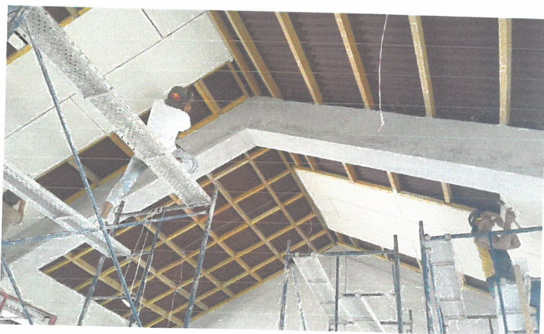
FOTO N° 13.- Colocación de dameros como entramado para recibir el cielo raso de plancha panel superboard
