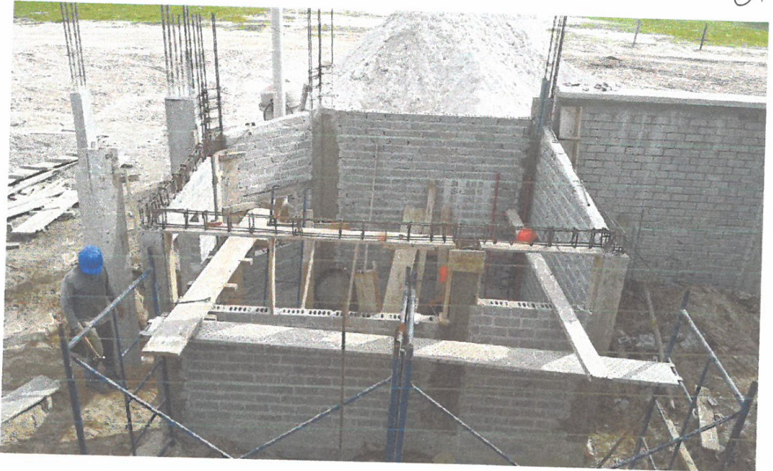
FOTO N° 03. Otra vista específica del avance de los trabajos en caseta de control de acceso a la institución Educativa
